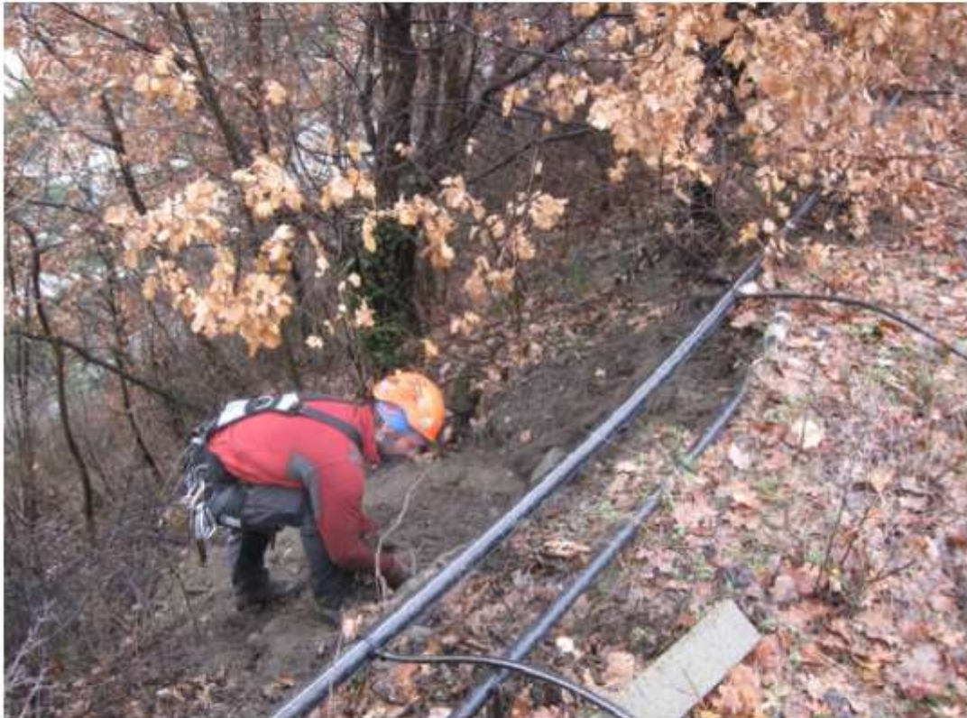
Operazione di pulizia della nicchia di distacco
