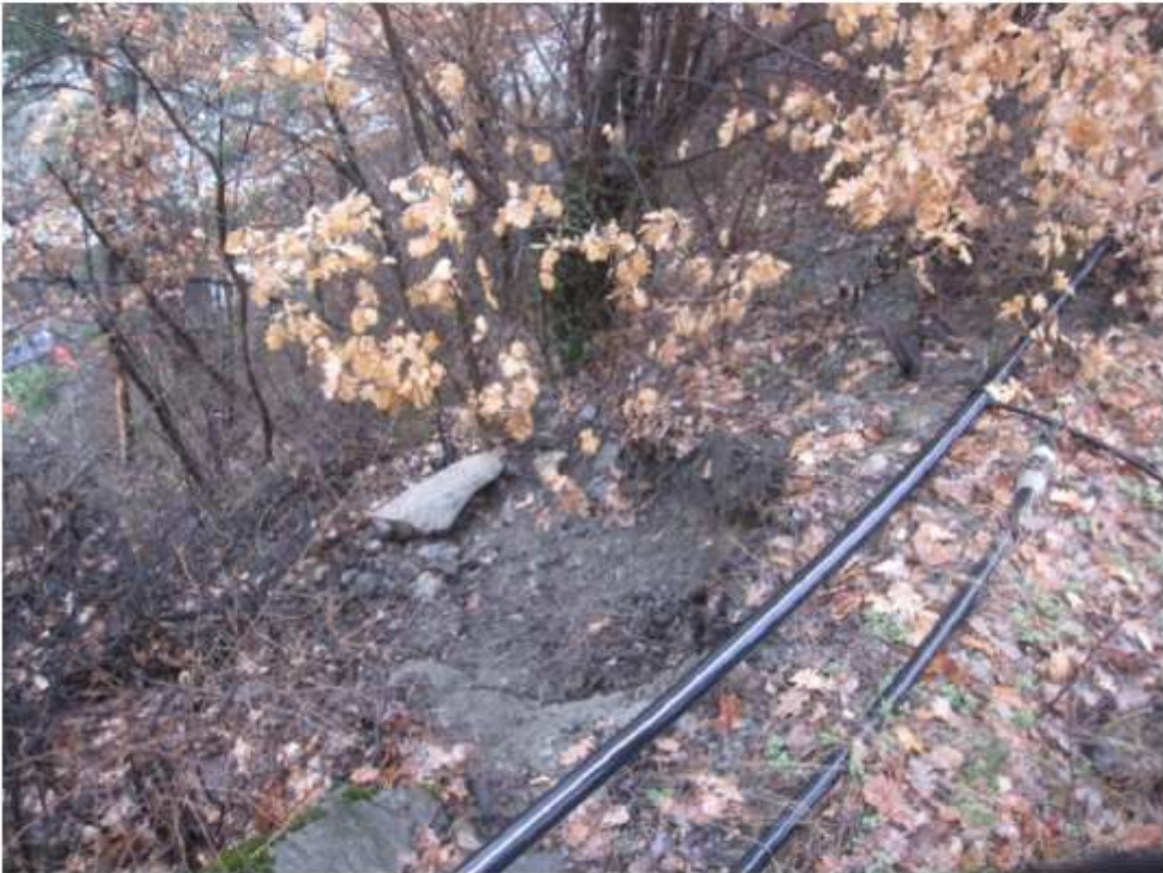
Nicchia di distacco con elementi lapidei in posizione instabile
